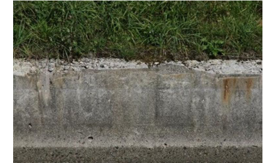
写真2 (開水路側壁天端)
